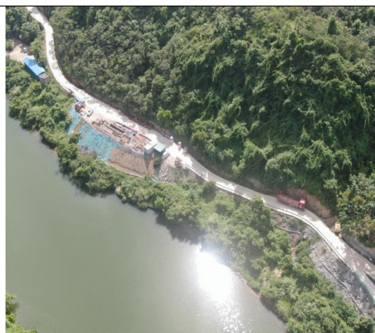
主体工程区临时拦挡及临时苫盖情况
