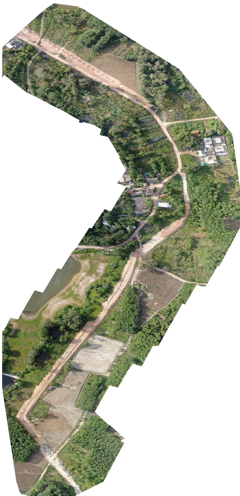
埇星支渠正射影像
