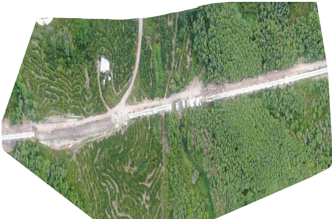
总干渠正射影像 1
