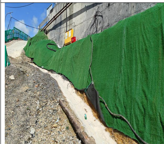
主体工程区临时排水及临时苫盖情况
