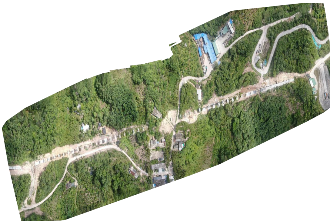
总干渠正射影像 2
