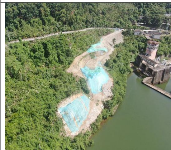
主体工程区临时苫盖情况 1
