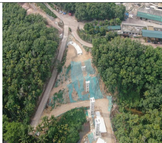
主体工程区临时苫盖情况 2
