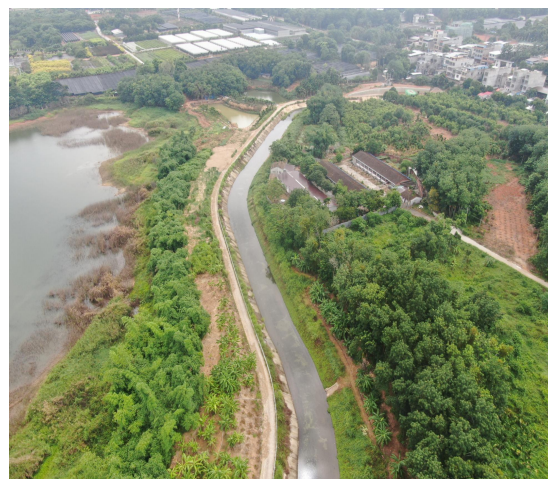
主体工程区植物措施实施情况（8）
