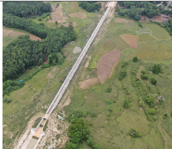
主体工程区植物措施实施情况（10）
