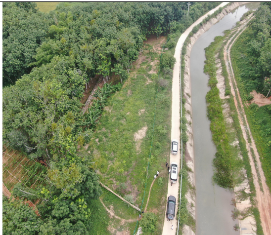
主体工程区植物措施实施情况（9）
