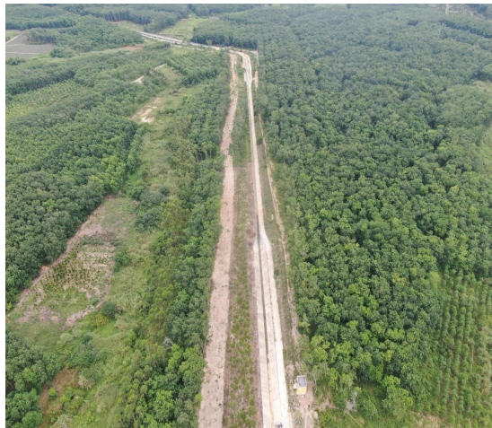
主体工程区植物措施实施情况（3）
