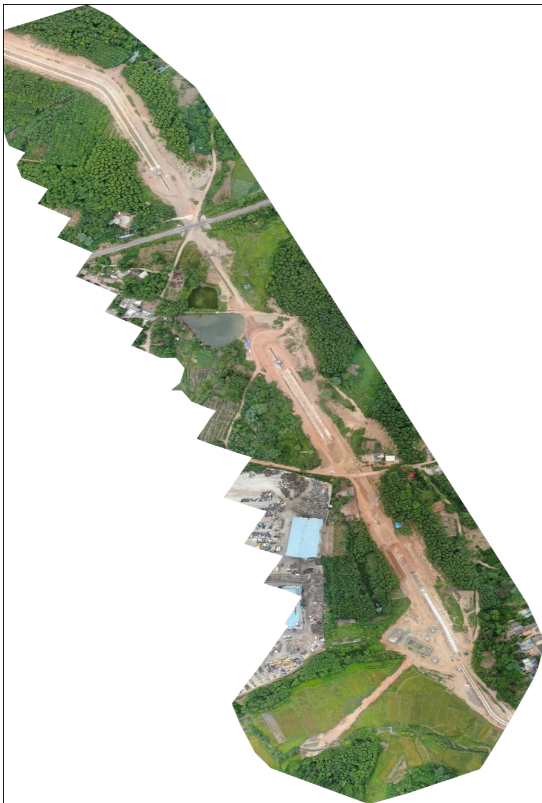
新建西干渠 1 正射影像
