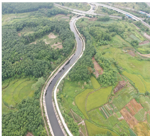
主体工程区植物措施实施情况（11）
