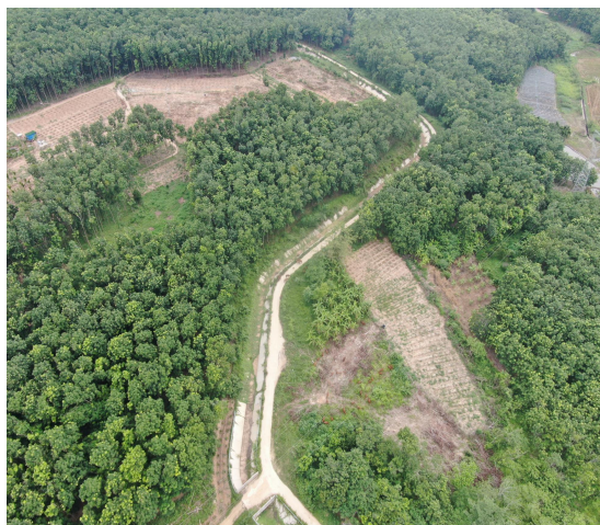
主体工程区植物措施实施情况（5）
