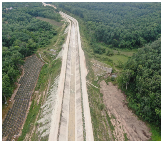
主体工程区植物措施实施情况（1）
