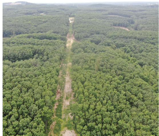
主体工程区植物措施实施情况（4）
