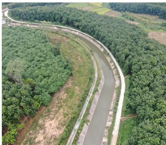
主体工程区植物措施实施情况（7）
